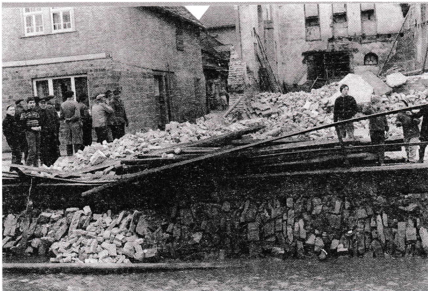
Beim Gebäudeabriss 1964 sind diese Gebäude- merkmale ein letztes Mal zu sehen.
