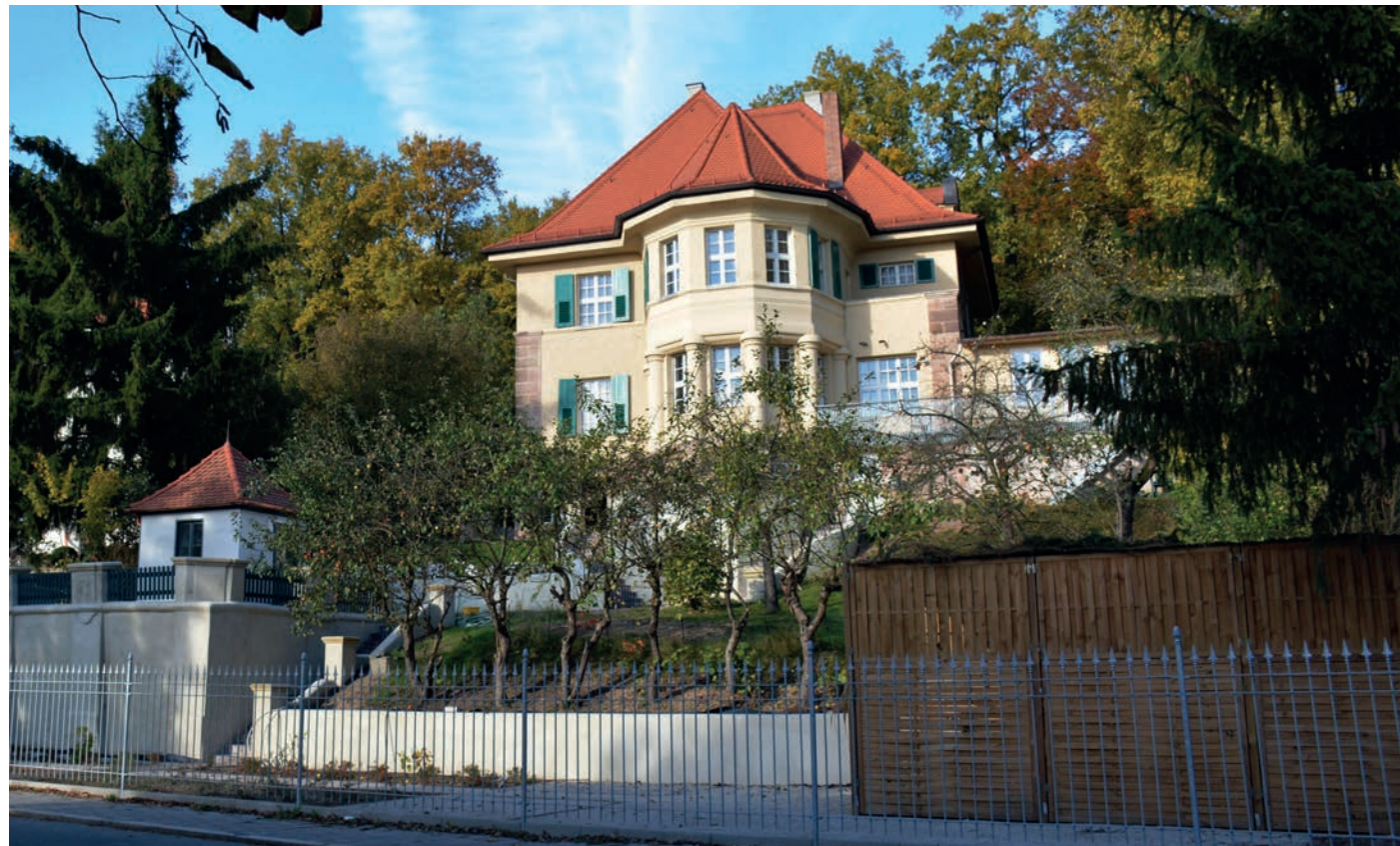
Abb. 6: Gemeindezentrum mit Synagoge von 2010
