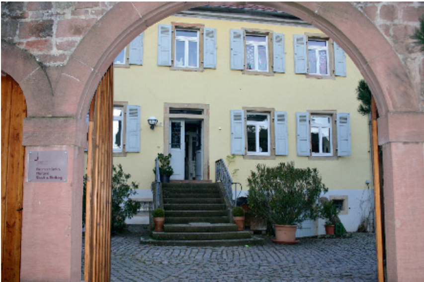
Wurde im Jahr 1750 erbaut: Das Pfarrhaus in Rhodt steht unter Denkmalschutz. (Foto: ckp)
