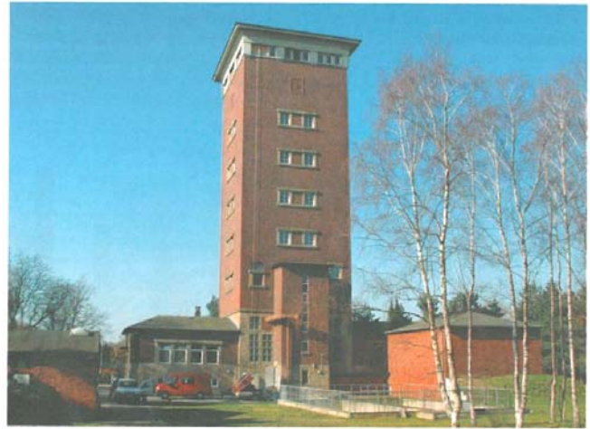
Der historische Wasserturm von Emsdetten
