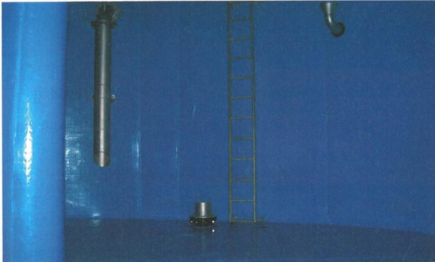
Abb. 8 b: Anwendungsbeispiel des Instandsetzungsprinzips A 4.2 mit Kunststoffplatten
