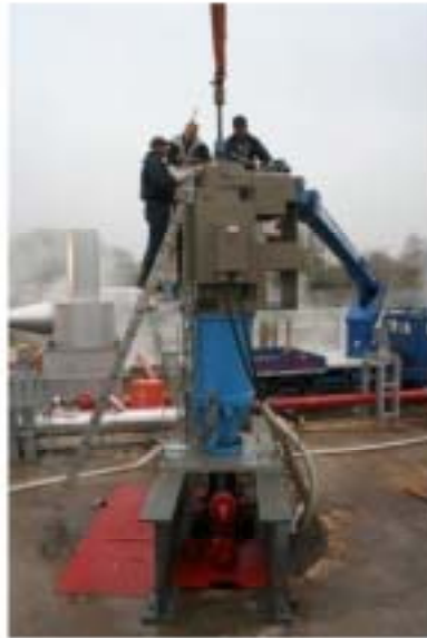
Justieren der Gestängepumpe
