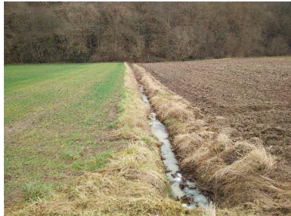
Graben im Süden
