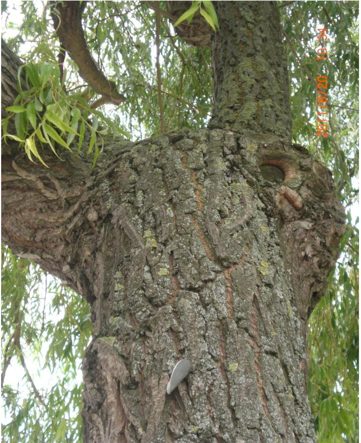
Abb.50: Blick in den Kronenbereich der Weide Nr. 12569
