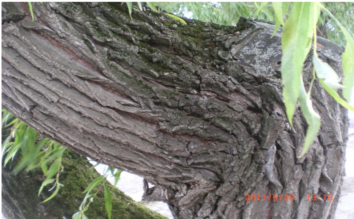
Abb.25: Unglücksbalken an Weide Nr. 12555
