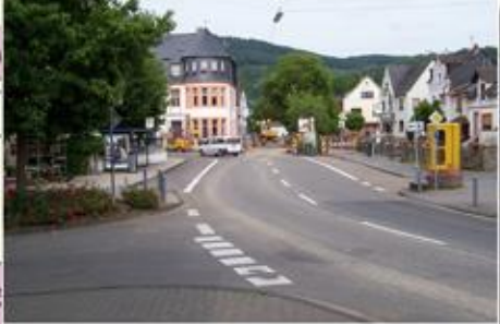
Verlegung der Bushaltespur
