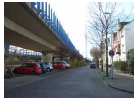
Abb.: Barriere „Raiffeisenbrücke“
