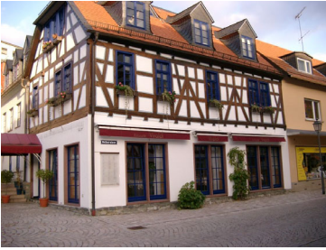
Markisen fügt sich in Gesamtbild des Gebäudes ein
