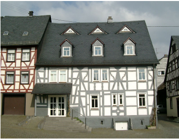
Schutzdach über Hauseingang
