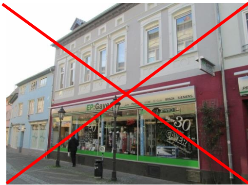
Negativbeispiele Gestaltung der Schaufensterzone
