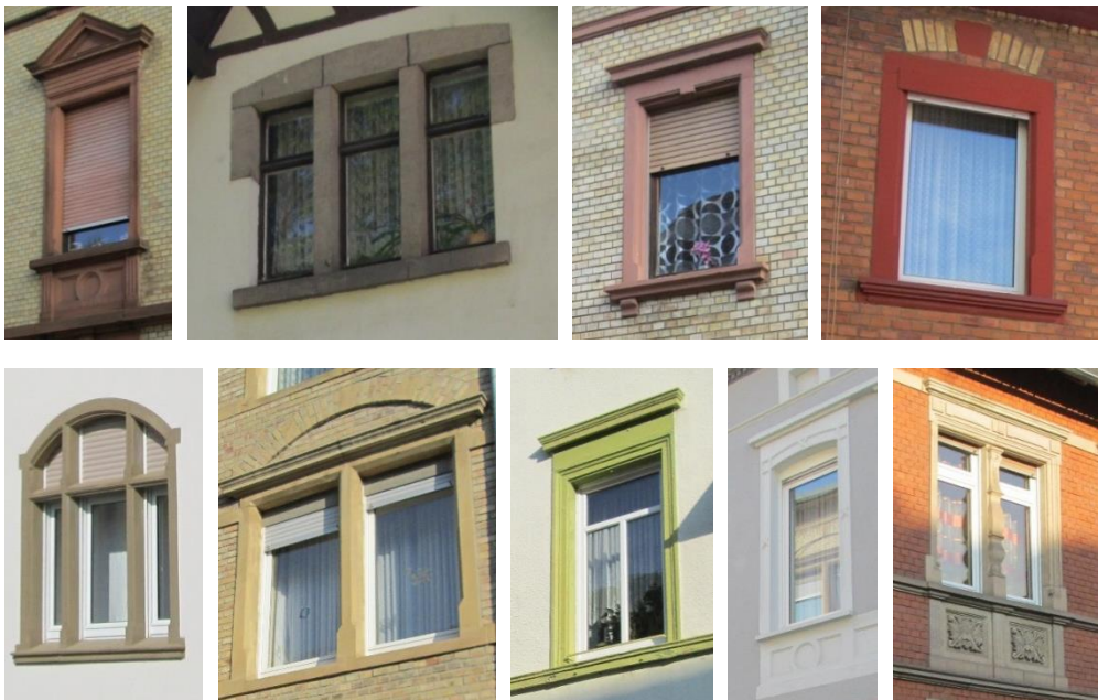
Vielfältigkeit der Sandsteingewände
