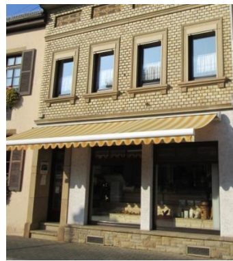
In Farbgebung und Form auf die Fassade abgestimmte Markise
