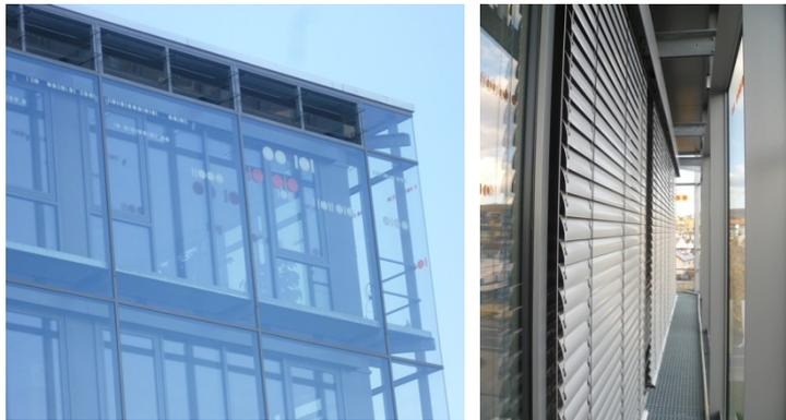
*Ansicht der Doppelglasfassade und des Fassadenzwischenraums: Außenluft strömt im Winter über geöffnete Klappen in den Fassadenzwischenraum, erwärmt sich dort durch solare Einstrahlung und wird anschließend zur Raumbeheizung und -belüftung genutzt. Im Sommer besteht bei nicht ausreichender Durchlüftung Überhitzungsgefahr.*
