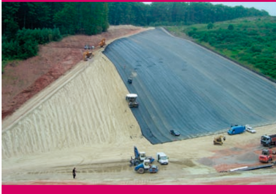
Prof. Tausch Bild 1: Basisabdichtung (Tonlagen + Asphalt) der Deponie Rechenbachtal, Zweibrücken
