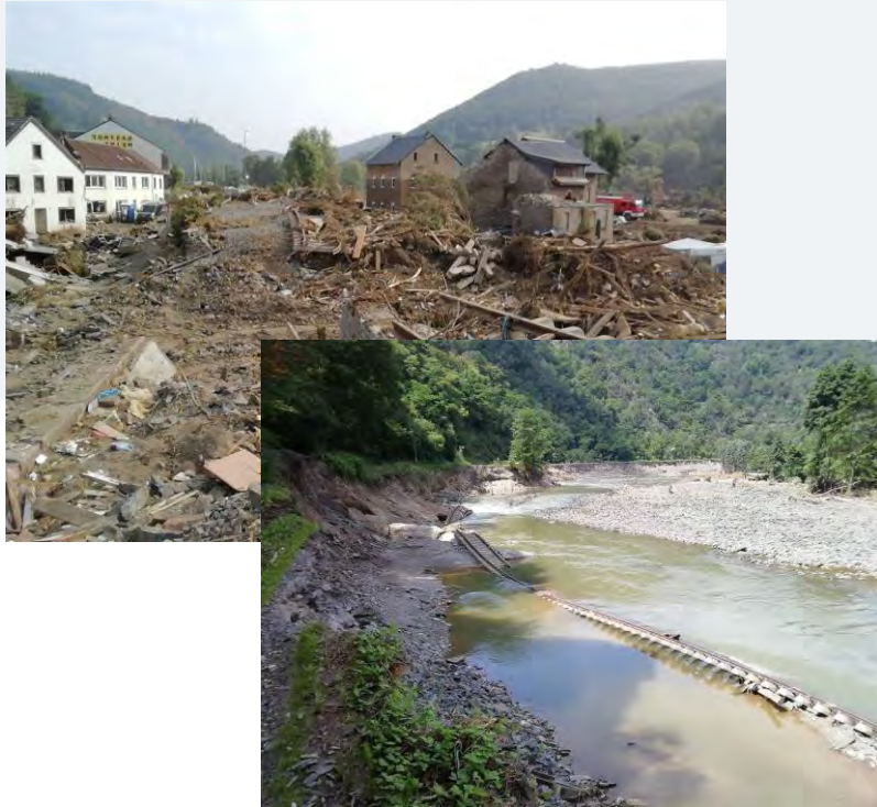
14 km Oberbau und Dammlage zerstört
