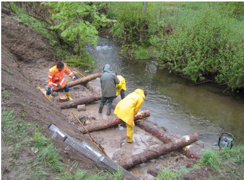
Fotos: LUBN Thüringen: Ingenieurbioologische Bauweisen zur Ufersicherung und Strukturverbesserung an Fließgewässern
