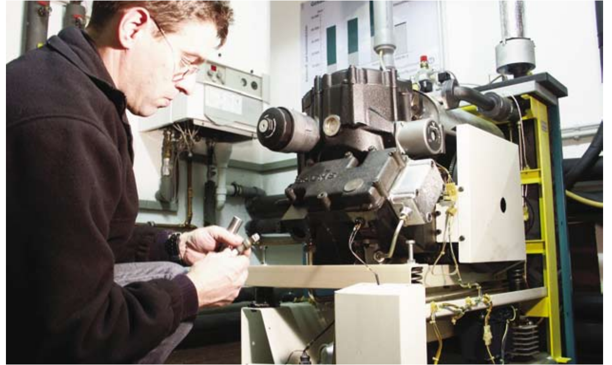
Auf der Suche nach effizientem Energieeinsatz für Gebäude beschreitet das Handwerk neue Wege, beispielsweise beim Einsatz von Blockheizkraftwerken, die Wärme und Strom produzieren. Dank individueller Beratung und Vor-Ort-Service hat das regionale Handwerk hierbei gute Chancen, neue Märkte zu erobern oder auszubauen. Foto: Diester
