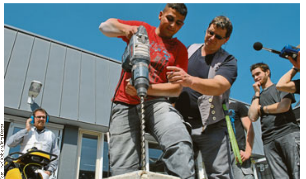
Gehörschutz im Ohr und das Messgerät liefern konkrete Zahlen zur Lautstärke der Arbeit mit dem Bohrhämmer – so erlebten kürzlich Lehrlinge der Bauberufe bei der Handwerkskammer Koblenz den „Tag des Lärms“ in Theorie und Praxis
