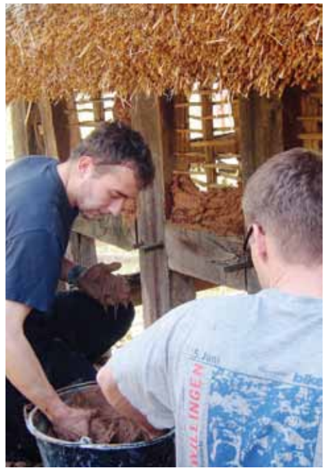
Fachgerecht mauern die Teilnehmer während der Fortbildung Teile eines Fachwerkgebäudes mit Stakengeflecht und Lehmsteinen aus
