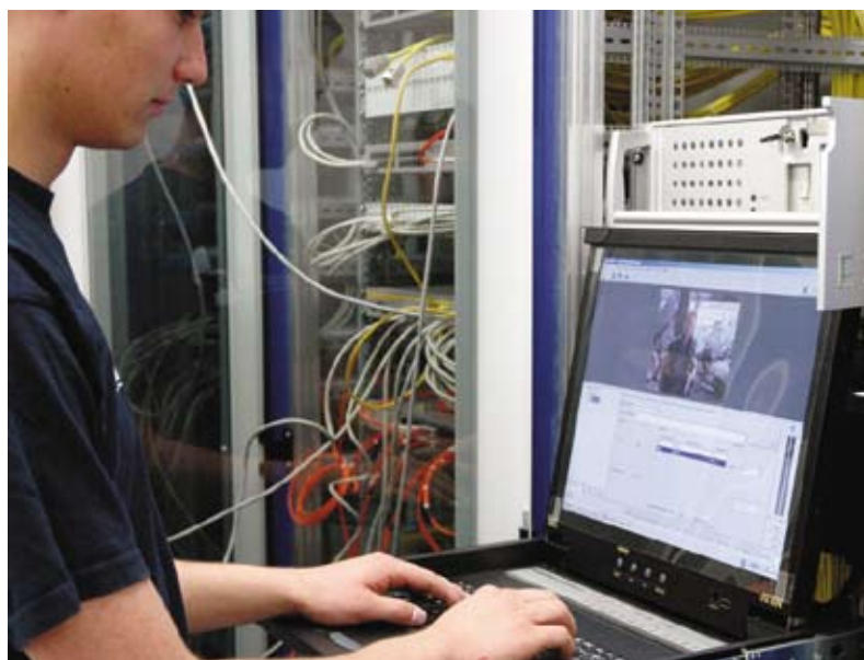
Netzwerk- und Server-, Steuerungs- und Regelungstechnik - im HWK-Kompetenzzentrum finden angehende Meister beste Lernbedingungen. Foto: Krause
