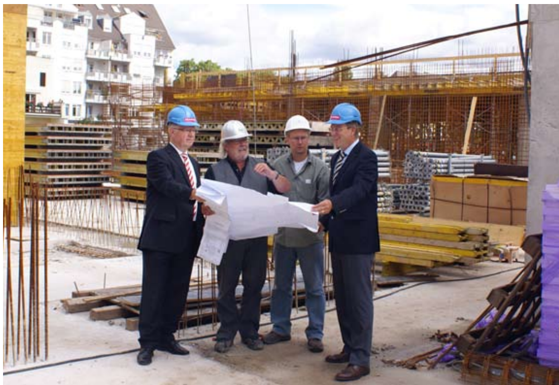
Besichtigen den Baufortschritt (v.l.): Präsident Werner Wittlich, Ulrich Brink (HwK-Bauzentrum), Frank Höser (Architekturbüro) und Hauptgeschäftsführer Alexander Baden
