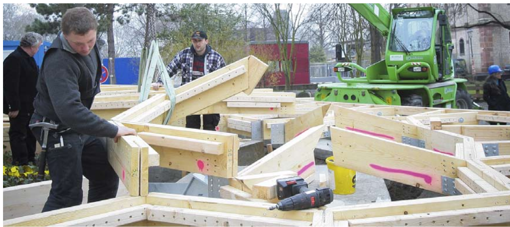
In Präzisionsarbeit werden die zahlreichen Einzelteile des BUGA-Pavillons von den Zimmerern montiert
