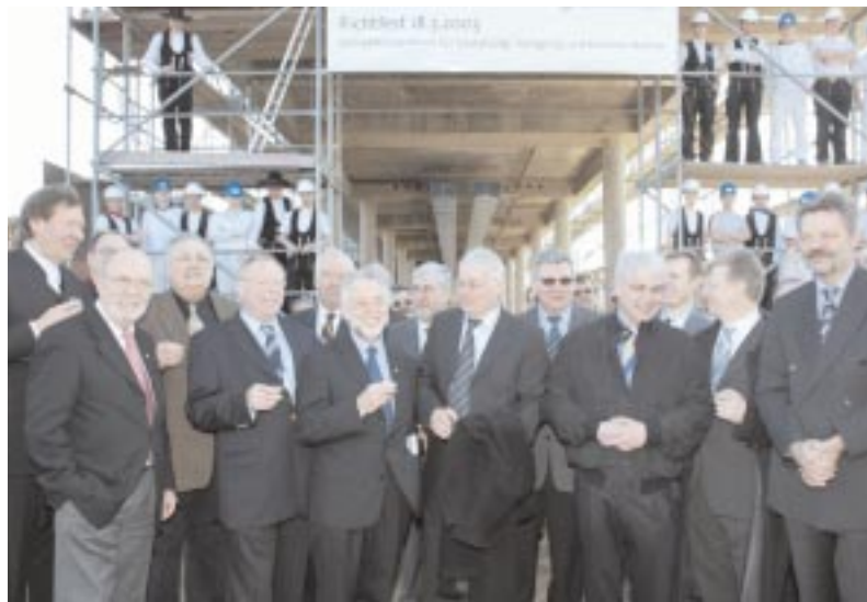
Das Handwerk stößt gemeinsam mit Vertretern aus Politik, Wirtschaft und Gesellschaft auf die Fertigstellung des Rohbaus an. Foto: Juraschek
