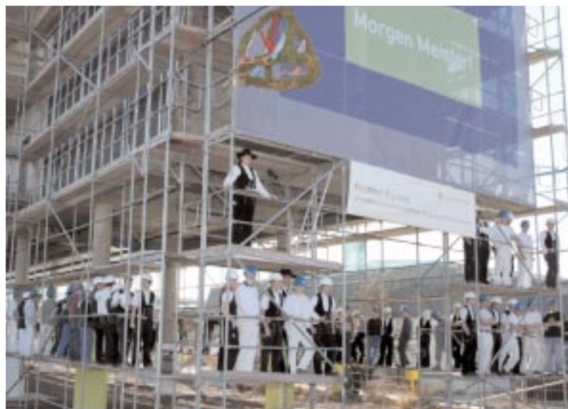
Das Handwerk feiert die Vollendung des Rohbaus mit dem Richtspruch durch HwK-Ausbilder und Zimmerermeister Tobias Allmoslöchner. Foto: Juraschek
