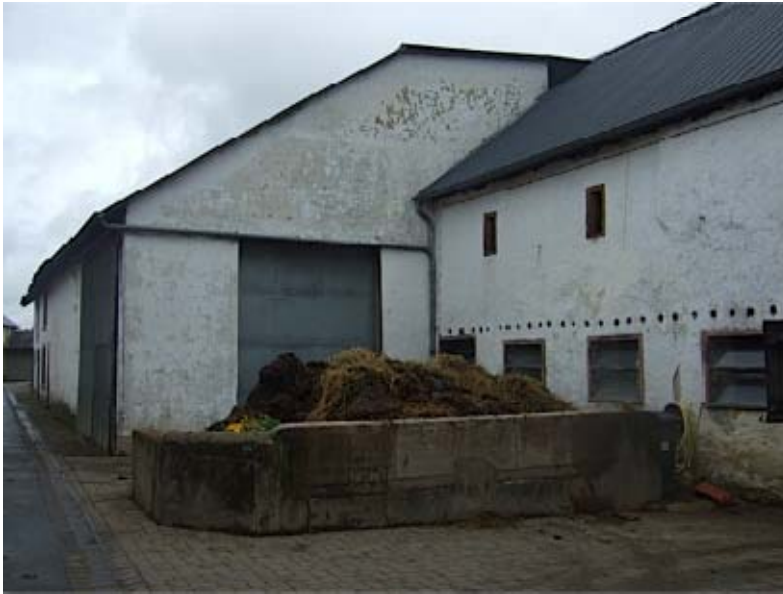
Abbildung 55: Kuhstall: Jagdhabitat der Wimper- und Bechsteinfledermaus, potenzielles Quartier der Wimperfledermaus
