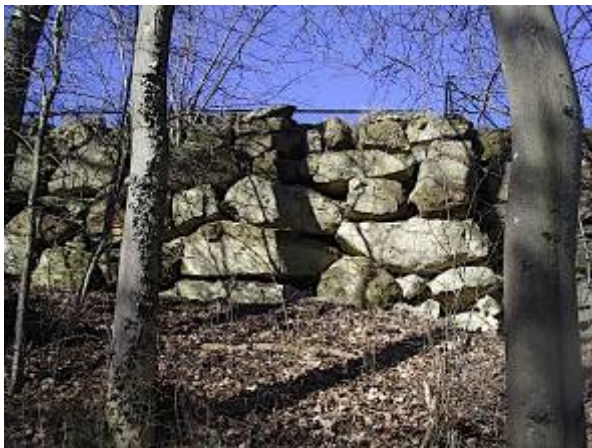
Abbildung 61: Spaltenreiches Mauerwerk, das ein hohes Quartierpotenzial aufweist.
