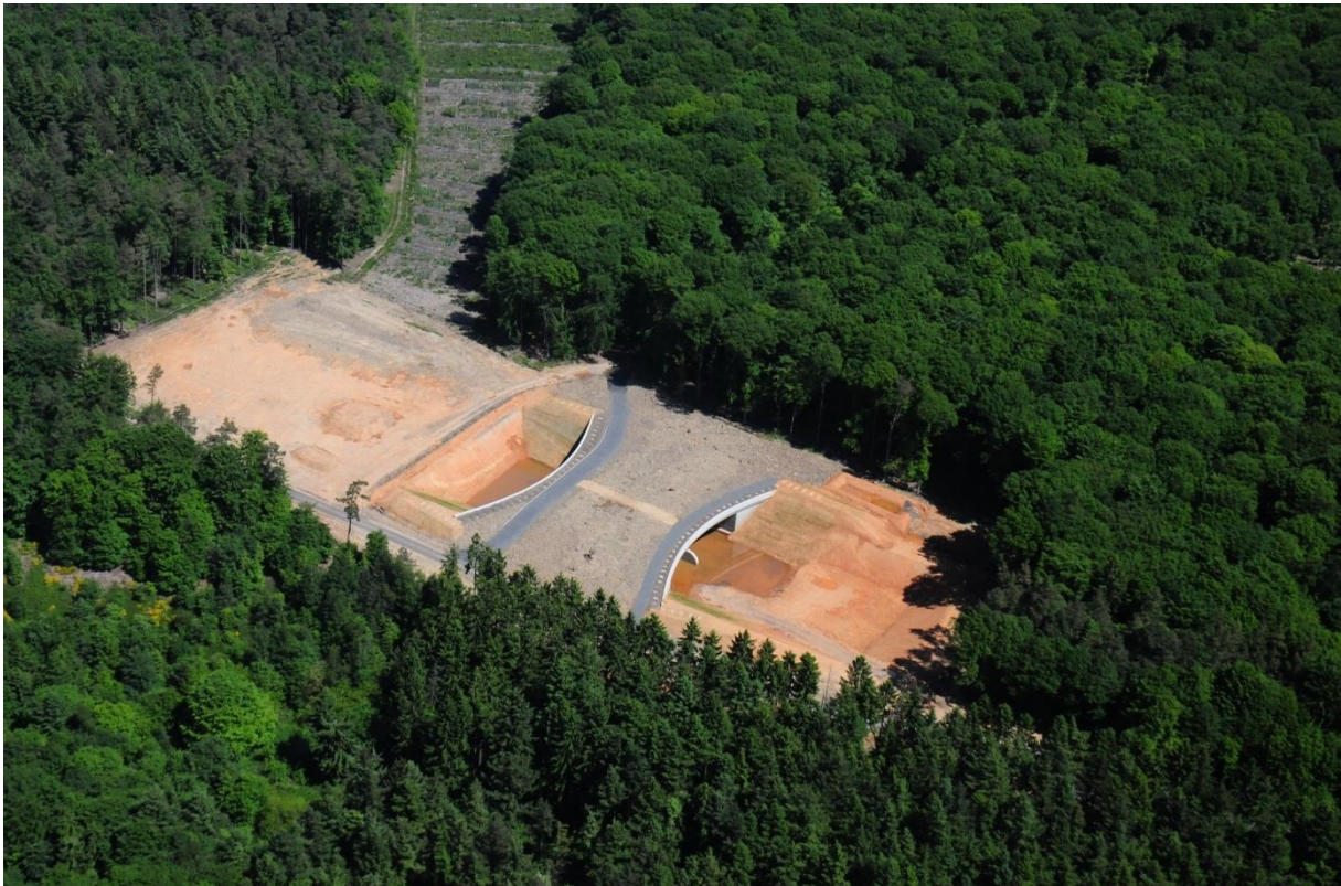
Abb. 1: Im Bau befindliche Grünbrücke an der B50 neu auf dem Moselsporn (2013).
