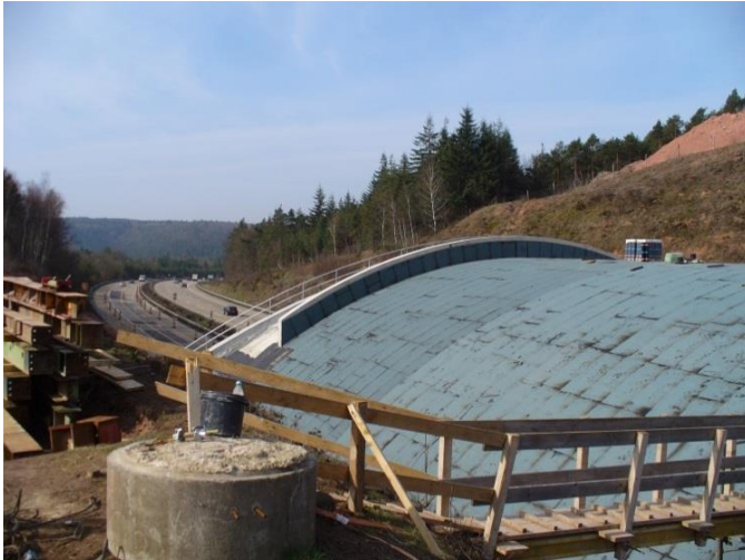
Abb. 20: Die Grünbrücke A6 Wattenheim im Rohbau.
