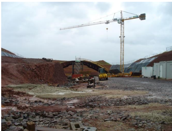
Abb. 10: Baustelle der Grünbrücke Haardter Weiher im Mai 2007.
