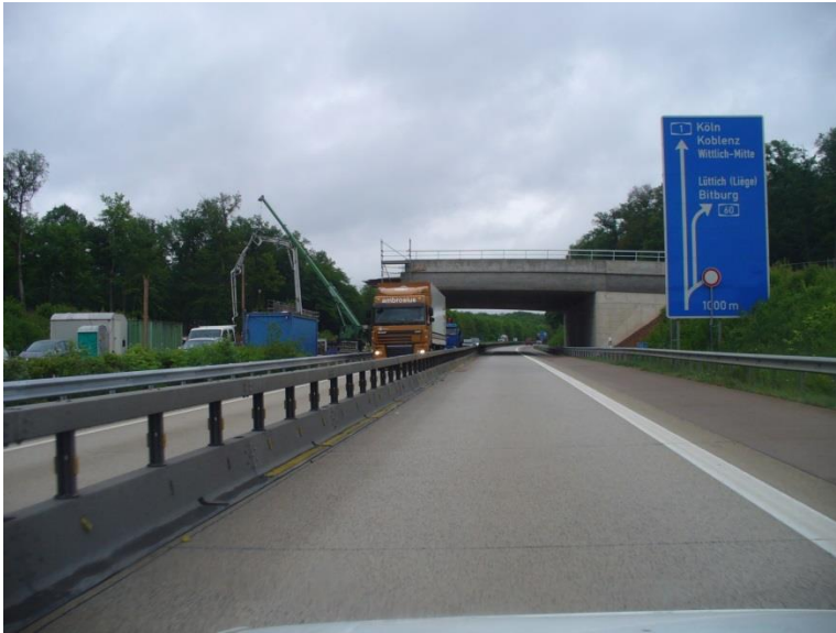
Abb. 8: Baustelle der Grünbrücke Wittlich (A1) (Mai 2007).
