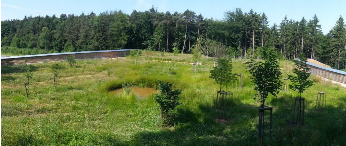
Abb. 16: Blick auf die Grünbrücke Greimerath (Blickrichtung West, Juli 2013).
