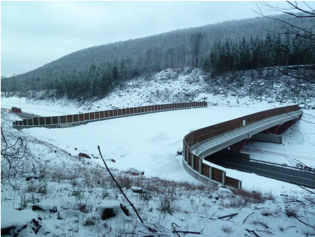
Abb. 22: Grünbrücke Walmersbach, Rohbau (23.1.2013).
