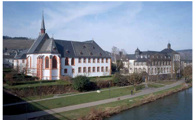
Kapelle und Ostfassade des St. Nikolaus-Hospitals / Cusanusstifts in Bernkastel-Kues.
