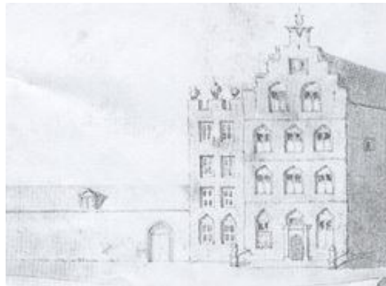
Das ehemalige Haus Clarenburg im Zentrum von Utrecht
