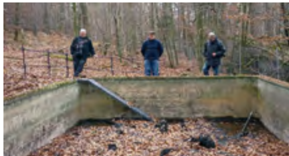
Durchführung: Metallwerkstätte Schary
