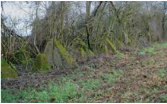
Nordansicht / vor der Anlage Acker mit Gründung
