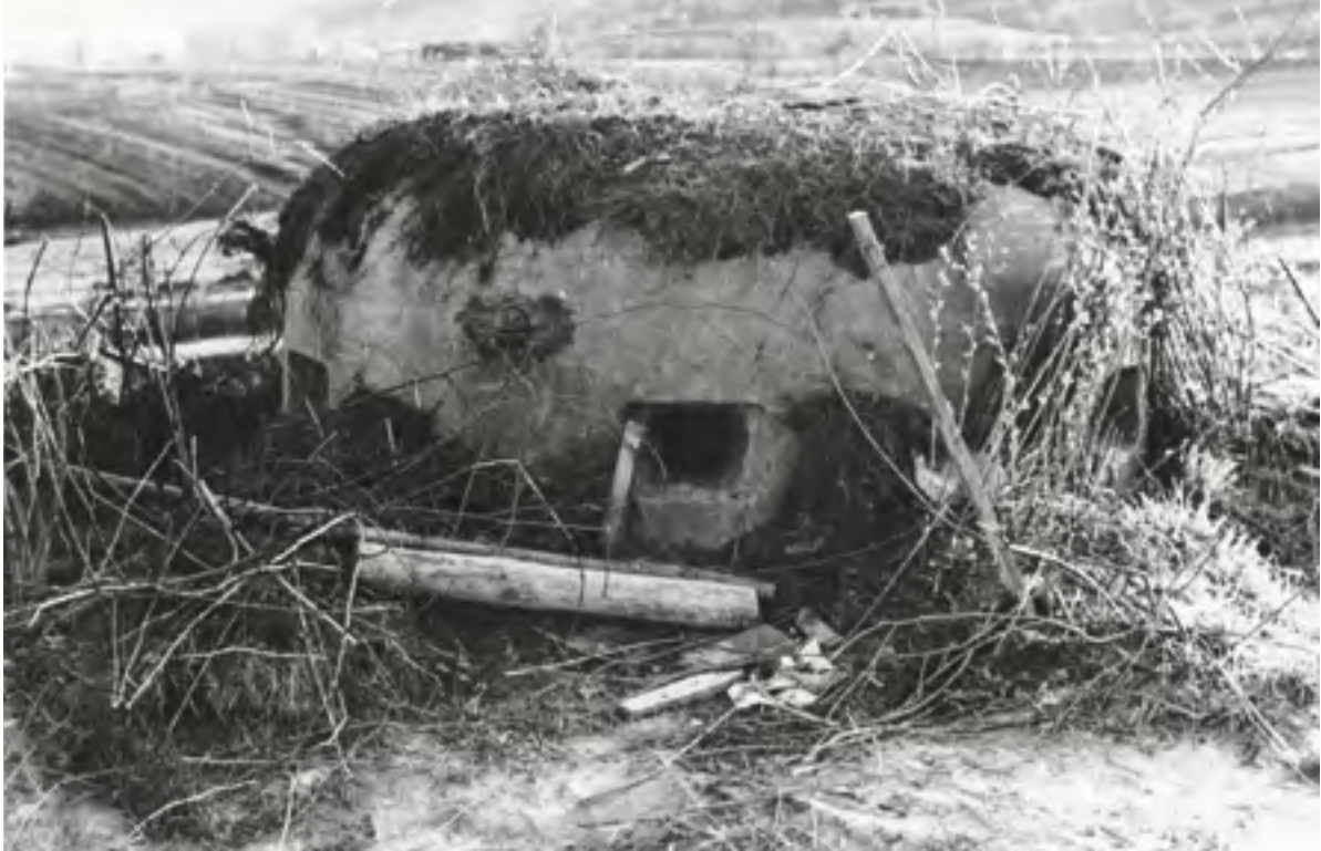
„Bei Bergzabern. 20.4.1940 Kaserne unter der Erde. Dieser getarnte Panzerturm ist im Gelände kaum zu erkennen, ganz unsichtbar aber ist das große Verteidigungswerk unter der Erde. Pop-Kp. 612 Bildberichter: Erich Bauer " BArch Bild 146-1990-102-15A / Erich Bauer
