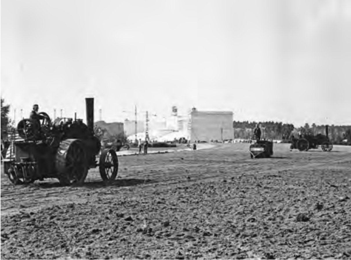
Anlage der Rasenstraße 2 zum Zeppelinfeld, um 1938 Dokumentationszentrum Reichsparteitagsgelände 259.18
