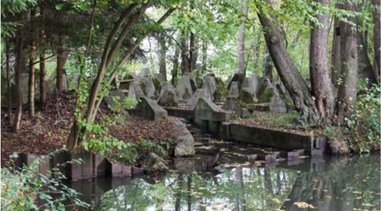
Panzergraben bei Niederrotterbach
