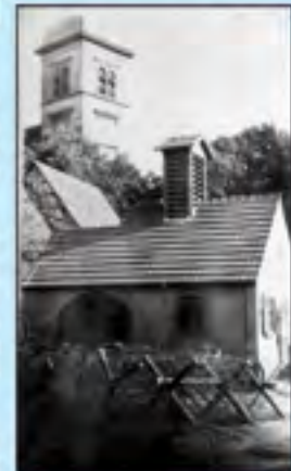
Was wie ein Feuerwehrhaus aussieht, ist ein Maschinengewehrbunker mitten in der Ortschaft vor der katholischen Kirche.
