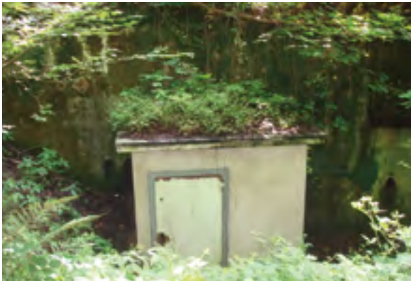
Vom Zivilschutz umgebauter Westwallbunker bei Saarbrücken Foto: E.-R. Hönes
