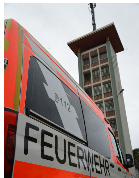
Die alte Feuerwache am Barbarauerfer soll durch einen modernen Neubau ersetzt werden - inklusive einer neuen Rettungsleitstelle für die Region Trier.
