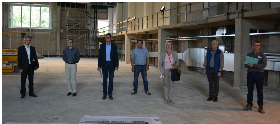
Landrat Günther Schartz (3.v.l.) überzeugte sich vor Ort von dem Baufortschritt der Sporthalle am Schulzentrum Schweich.
