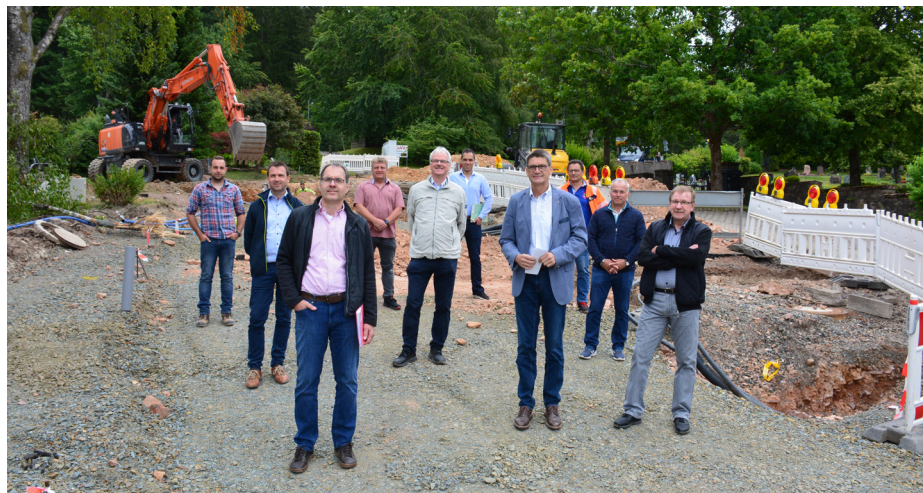
Auf der letzten Station der Kreisstraßen-Tour machte sich Landrat Günther Schartz (3. v.r.) gemeinsam mit Vertretern des Landesbetrieb Mobilität sowie der Ortsgemeinde ein Bild der Baumaßnahme in der Hochwaldgemeinde Damflos.
