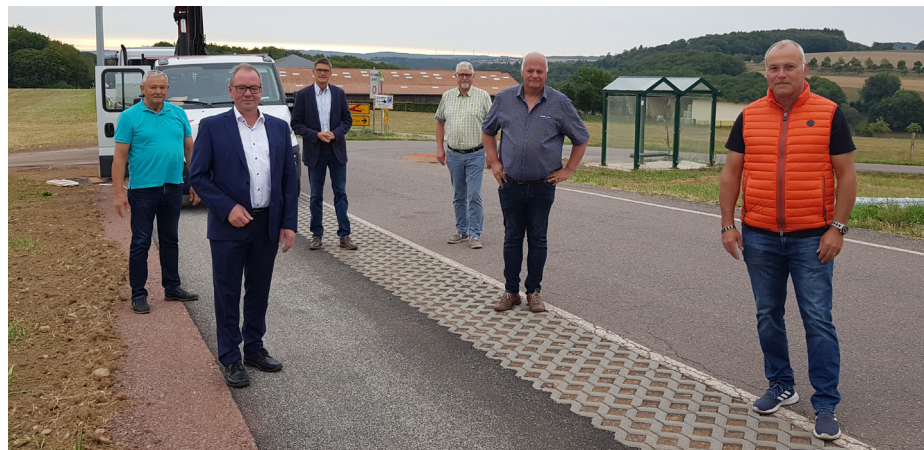
Der neue Fußweg verbindet der Ort Portz mit der außerhalb des Dorfes gelegenen Bushaltestelle. Im Hintergrund werden die Straßenlaternen errichtet.
