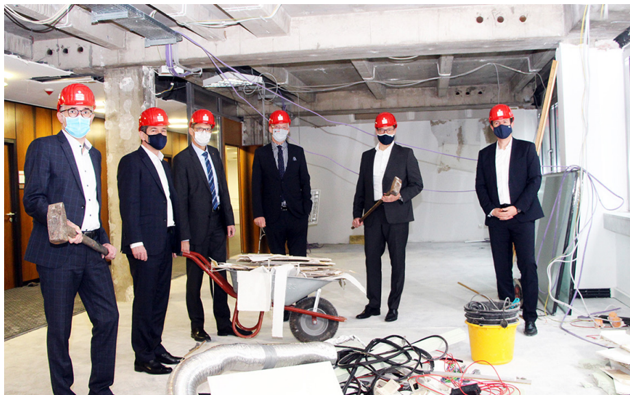
Landrat Günther Schartz (3.v.l.) und Oberbürgermeister Wolfram Leibe (4.v.l.) schwingen zusammen mit dem Vorstand der Sparkasse Trier und dem Projektleiter Thomas Schmidt (1.v.r.) den symbolischen Abrisshammer.
