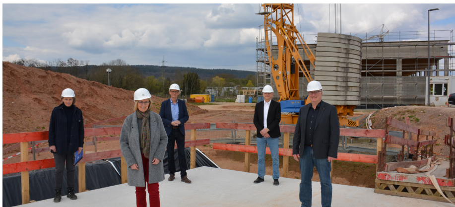
SGD-Nord-Präsident Uwe Hüser (rechts) machte sich zusammen mit (von links) Architektin Ulrike Stein, Bürgermeisterin Christiane Horsch, Landrat Günther Schartz und Thomas Vogt von der oberen Bauaufsicht der SGD Nord ein Bild von den Baumaßnahmen.
