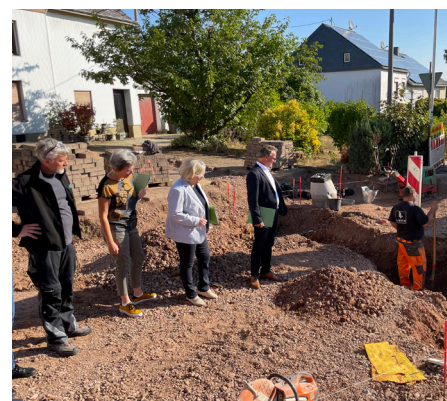
Landrat Metzdorf informiert sich bei den Bauarbeitern über den Fortschritt des Ausbaus der Kirchstraße in Gutweiler.
