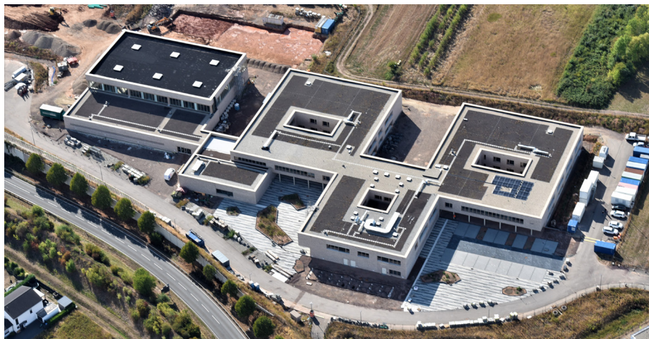
Der Bau des Gebäudeensembles beim ISP in Schweich macht deutlich Fortschritte. Dennoch gibt es unter anderem durch Lieferengpässe Verzögerungen.
