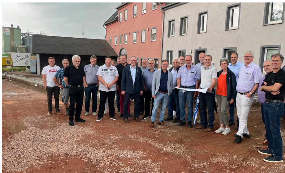
Der Bauausschuss besichtigte unter anderem den Ausbau der Ortsdurchfahrt Merzkirchen in der Verbandsgemeinde Saarburg-Kell.
