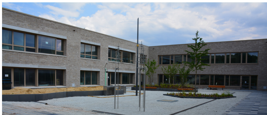
Die Außengebäude sind im wesentlichen fertiggestellt. Nun wird im Inneren des Neubaus in Schweich gearbeitet.
