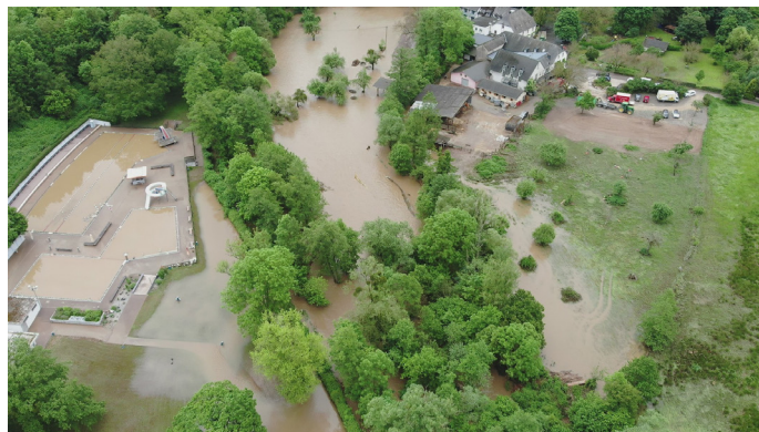
Entlang der Ruwer waren in vielen Ortsgemeinden Straßen und Häuser überflutet - das Bild wurde von einer Drohne gemacht und zeigt das überschwemmte Freibad in Mertesdorf.
