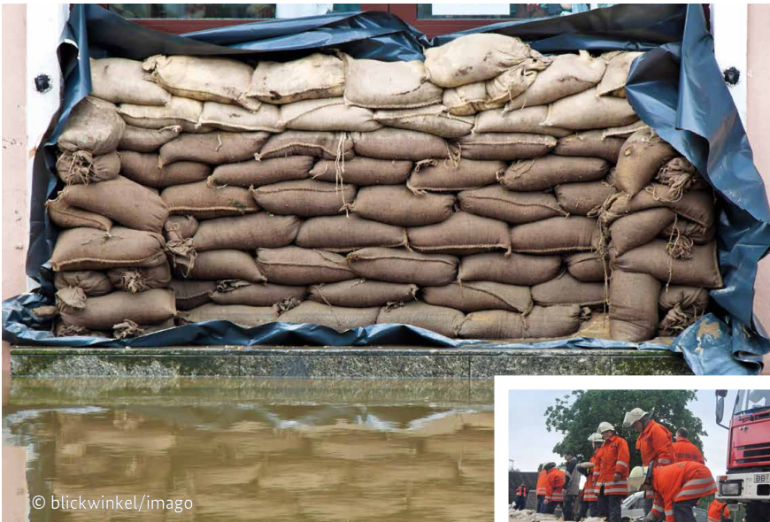
Schutzwälle aus Sandsäcken
