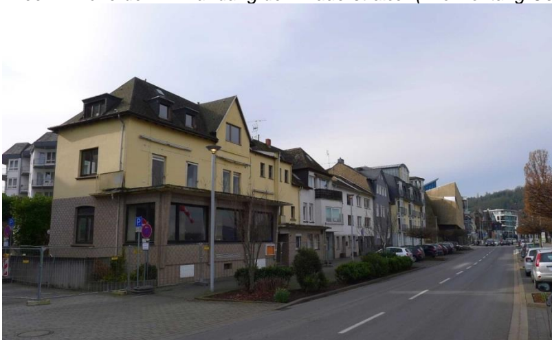
Abbildung 12: Blick auf die Bebauung im Plangebiet, aufgenommen von der `Konrad-Adenauer-Allee` in Höhe der Einmündung der `Mauerstraße` (Blickrichtung Osten → Westen)
