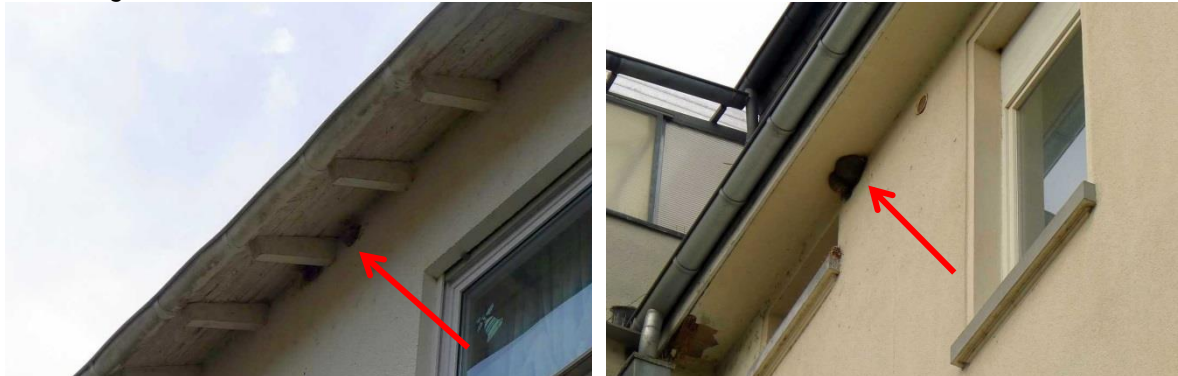
Abbildung 20: Schwalben-Nester unter Dachüberständen
