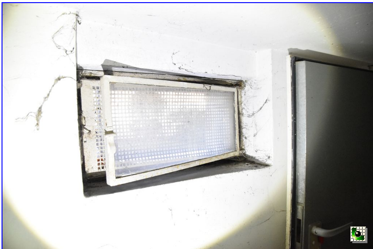
Abb. 7: Kellerbereich mit durch Lochblech verschlossenem Lichtschacht
