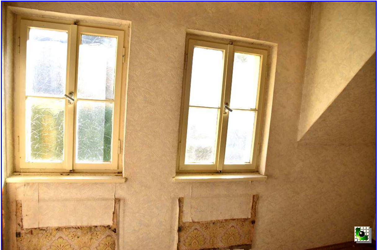
Abb. 11: Geschlossener Raum im DG
