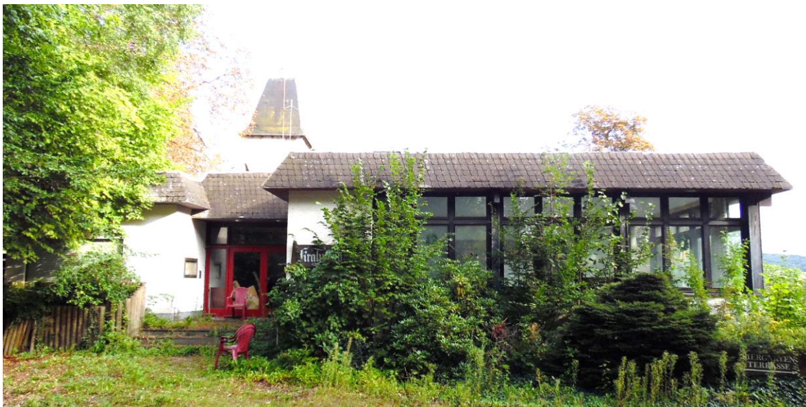
Abbildung 3: Zustand der Bausubstanz im Frühjahr 2019 (Quelle: André M. Amerkamp, Architekt / Dipl.Ing.FH)
