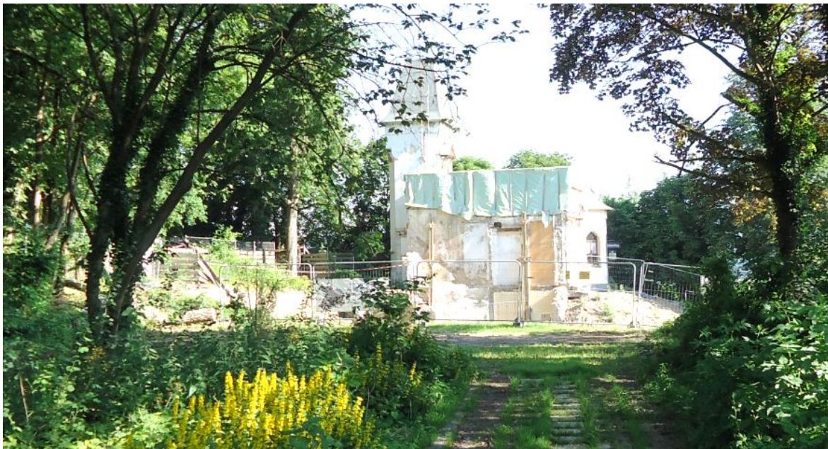
Abbildung 5: Zustand des Geländes nach den Rückbauarbeiten (Juni 2019)
