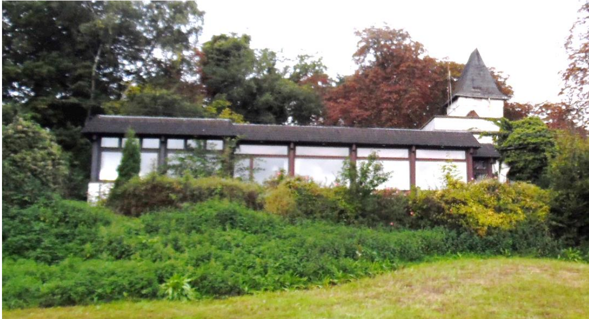
Abbildung 4: Zustand der Bausubstanz im Frühjahr 2019
