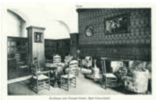
4.51-Pk-00569 Innenraum / Halle im Kurhaus
