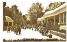
4.51-Pk-00556 Radium Solbad Kreuznach , Kurhaus und Palasthotel Kurhaus mit Wandelhalle und Musikpavillion
