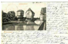
4.51-Pk-01236 Bad Kreuznach. Alte Festungsmauer
