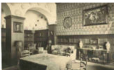
4.51-Pk-00570 Innenraum / Halle im Kurhaus
