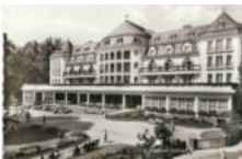
4.51-Pk-00562 Bad Kreuznach, am Kurhaus Kurhaus (Seiteneingang)
