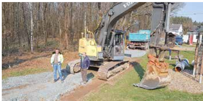
v.l.: Björn Müller (VG-Verwaltung) und Martin Giehl (Fa. Giehl Tiefbau) bei der Begutachtung des Baufortschritts am Spielplatz Foto: Röder-Moldenhauer
