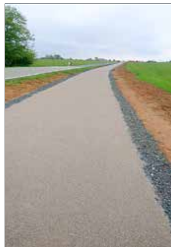
Neu eingebaute Deckschicht braucht Liegezeit zur Aushartung
