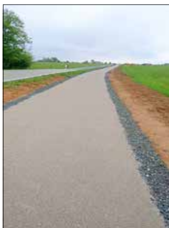
Neu eingebaute Deckschicht braucht Liegezeit zur Aushärtung
