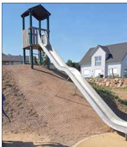
Ausgelegte Matten unter der Hangrutsche am Mehrgenerationenspielfeld
