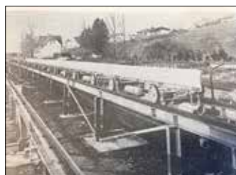
(li.) Zug mit Fahrwerk auf Rollen und (re.) Trogförmiges Gummiband eingehängt am Rollen-Fahrwerk des Zuges
