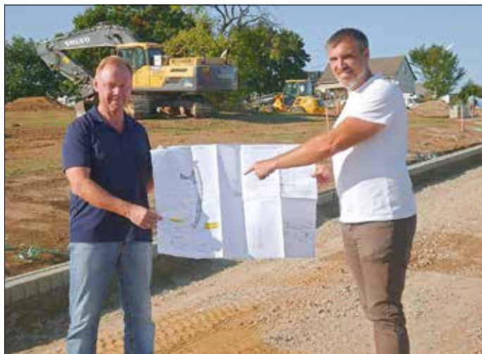
Björn Müller von den Verbandsgemeindewerken (rechts) erläutert Ortsbürgermeister Volker Uhr den Fortgang der Erschließungsarbeiten im Baugebiet „Breite Bitz II“.
