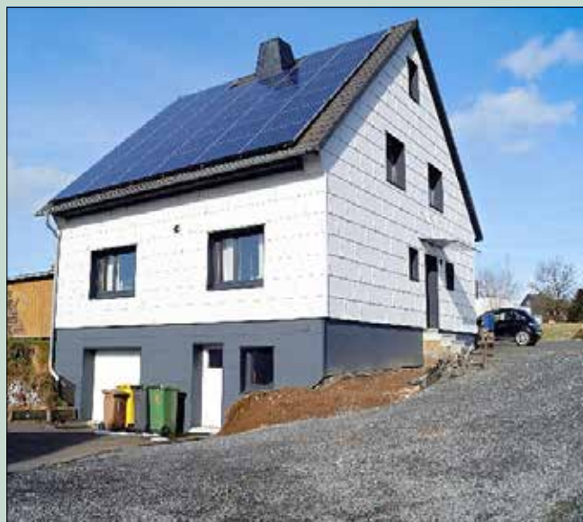
Seit dem 01.01.2022 ebenfalls forderfahig: Energetische Sanierungen an der Gebaudehulle wie etwa die Fassadenerneuerung. Foto: privat
